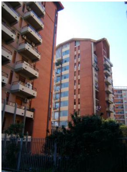
Accesso Via Aldebaran
