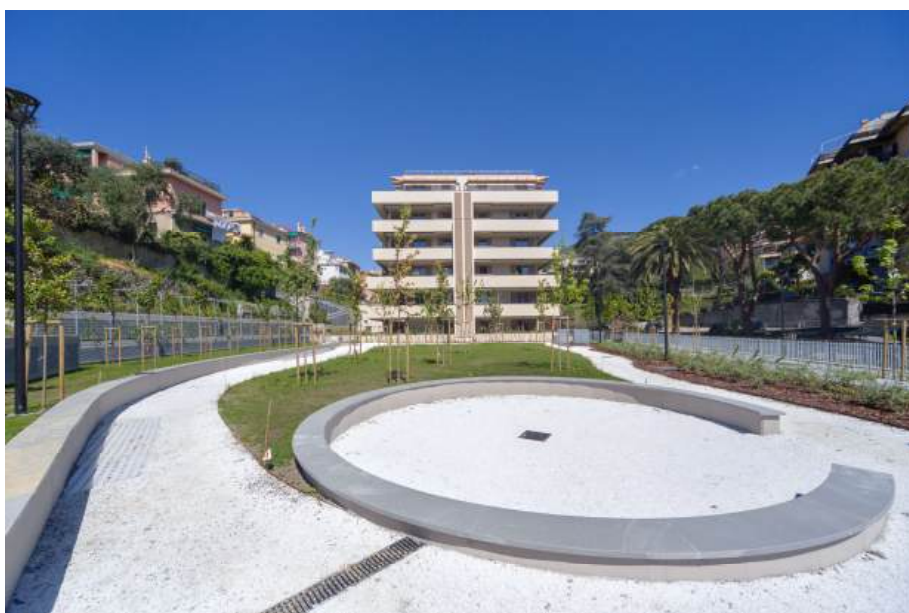
Ingresso box e piastra piano seminterrato – 1
