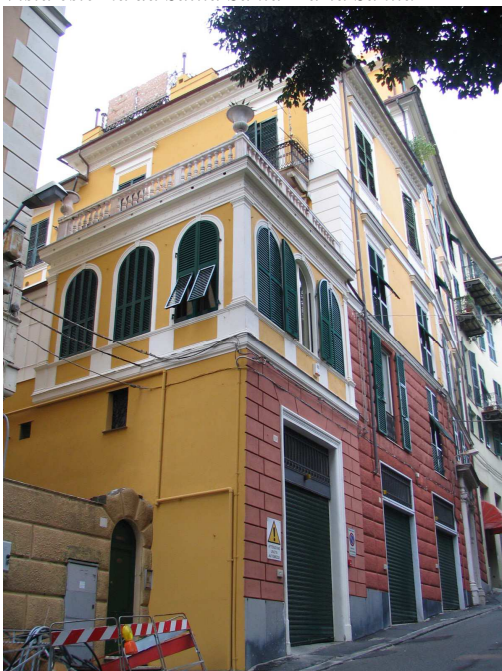
Vista esterna da Salita Santa Maria Sanità
